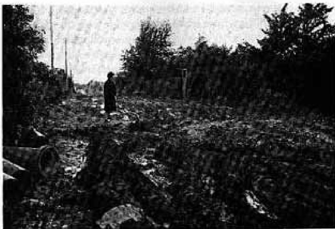
Kloakering på Bregnevej, August 1963
